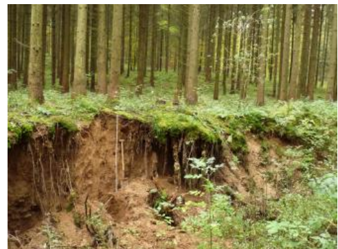
Bewaldete Trockentalmulde nordöstlich von Osterburken mit Kolluvium
