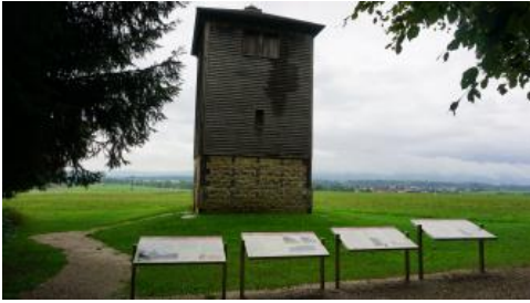
Rekonstruktion eines römischen Wachturms am Obergermanisch-Raetischen Limes bei Rainau
