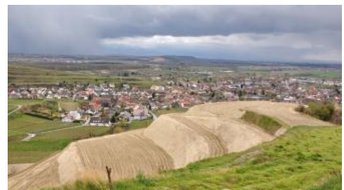
Anlage neuer Lössterrassen bei der Flurneuordnung Ihringen 2014
