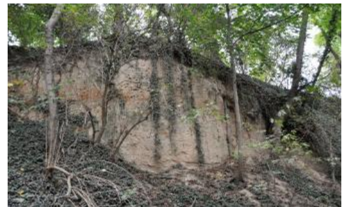
Lösswand in einem Hohlweg südöstlich von Buggingen
