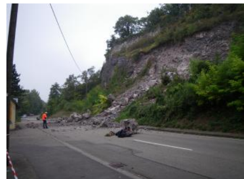
Felssturz in Sasbach unterhalb der Ruine Limburg
