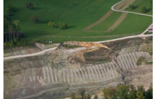
Böschungsrutschung an der Autobahnbaustelle A98.4 bei Minseln
