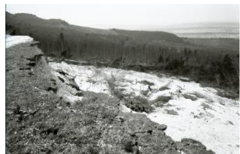
Untergeordnete Abrisskante mit „Kieswüste“
