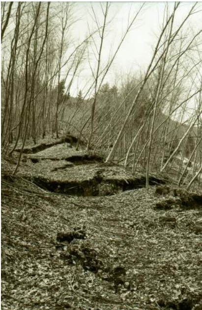
Zerrspalten und Absetzungen innerhalb der Horst-Struktur
