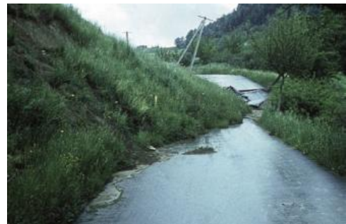
Durch die Hangrutschung Eichberg bei Blumberg-Achdorf zerstörte Kreisstraße (Aufnahmedatum unbekannt)
