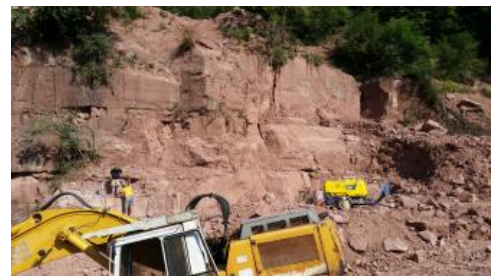
Durch Bohren und Keilen werden Rohblöcke gelöst.
