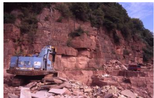
Weitständig geklüftete Sandsteine
