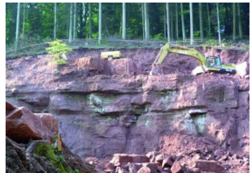
Bohren und Schneiden mit einer Seilsäge
