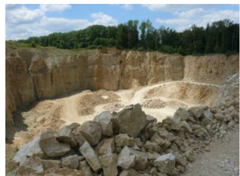
Die unterschiedliche nutzbare Mächtigkeit im Steinbruch Eigeltingen ist auf das Paläorelief zurückzuführen.
