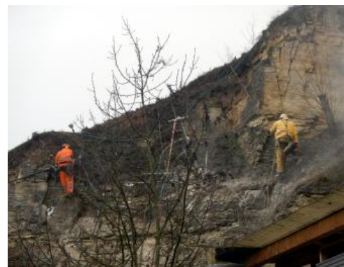
Arbeiten während Erstellung der Sicherungsmaßnahmen
