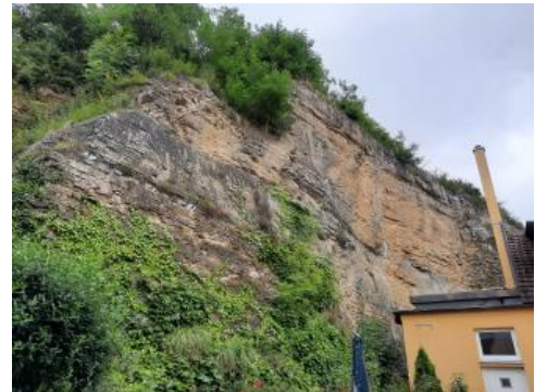
Ausschnittsweise Ansicht der ausgeführten Sicherungsmaßnahmen
