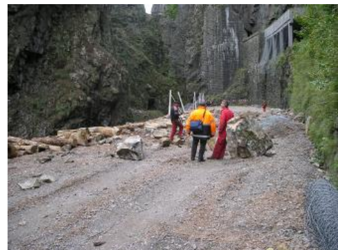
B31 während der Räumarbeiten
