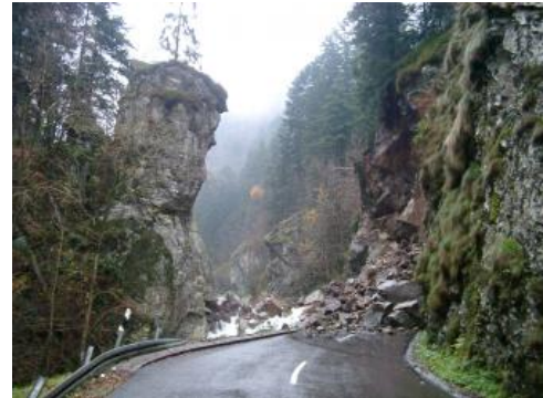
Sturzmassen auf der L 148, Lkr. Waldshut
