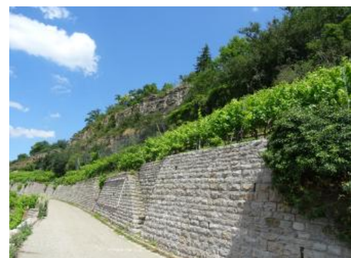
Unterhalb der Hessigheimer Felsengärten verlaufender Steinschlagschutzzaun
