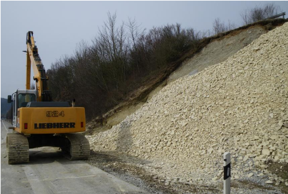
Abschließende Wiederaufbaumaßnahmen der Böschung am 17.03.2009
