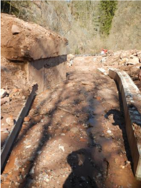
Blick vom Ausgang der Hangklinge entlang des hergestellten Entwässerungskanals durch die wassergesättigte Murgangablagerung in Richtung Schiltach
