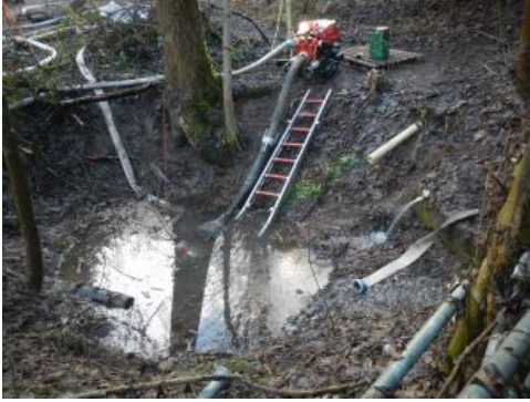
Eingerichteter, provisorischer Pumpensumpf, welcher in den ersten 48 Stunden durch die örtliche Feuerwehr betrieben wurde
