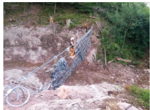
Installation eines dynamischen Murgangnetzes (Foto: Stadt St. Blasien)
