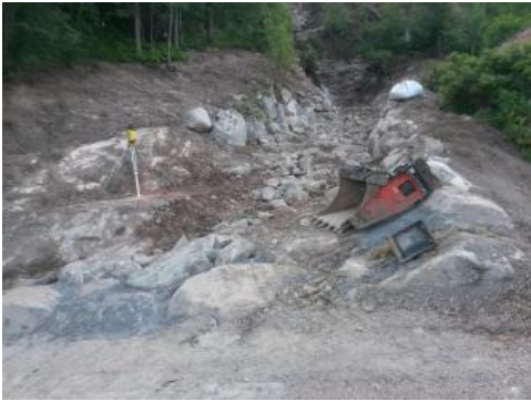
Begradigung des Oberen Großbachs oberhalb der neu angelegten Furt (Foto: Stadt St. Blasien)
