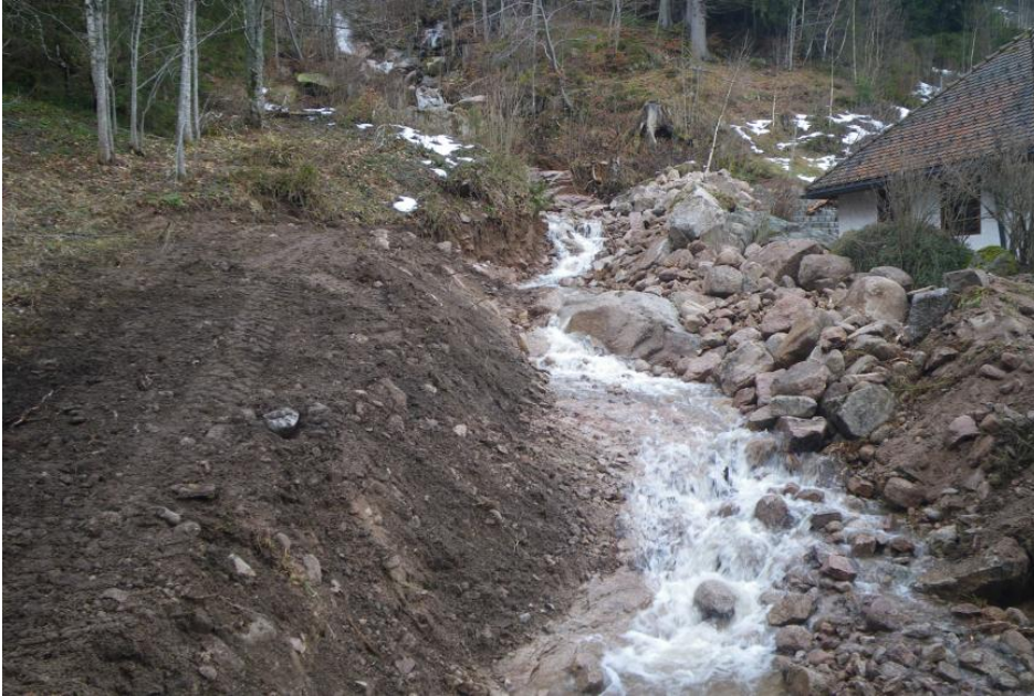
Aufschüttung eines Walls entlang des Bachufers auf Grundstück Nr. 8
