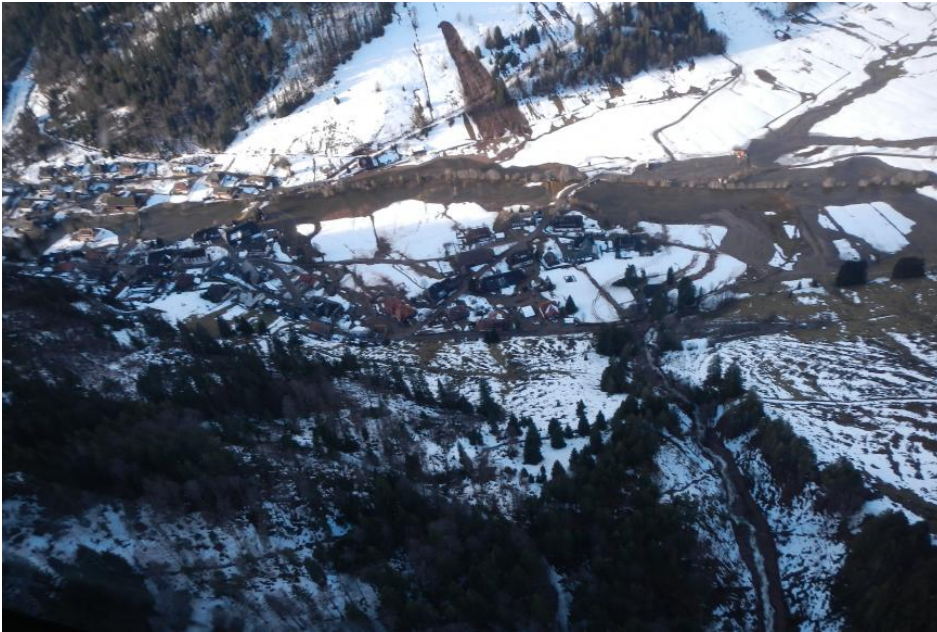
Luftbild der bebauten Ortslage nach dem Murgangereignis mit erkennbaren Fließpfaden (Aufnahme aus Polizeihubschrauber)
