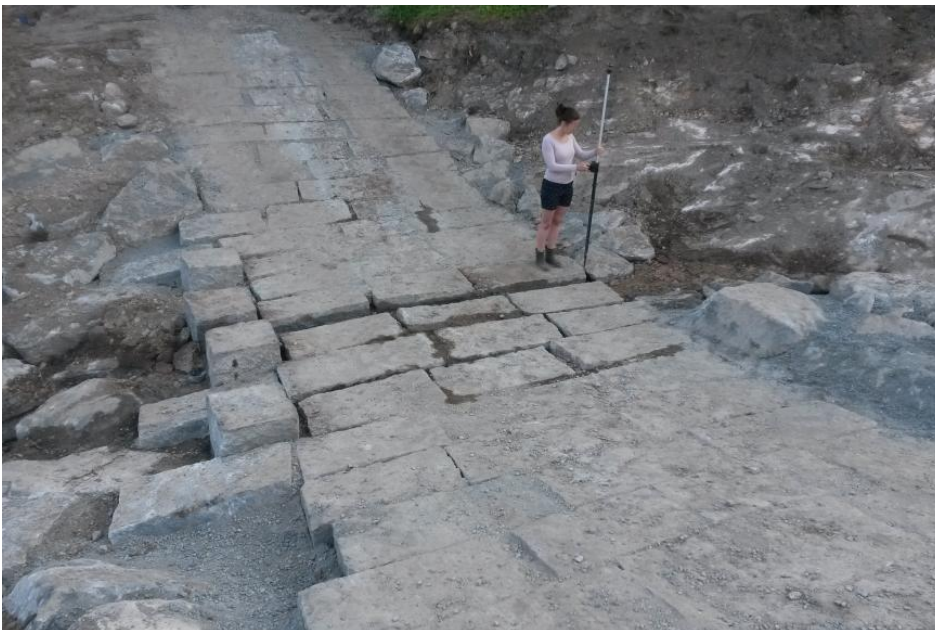
Ersetzen der Brücke am Schwarzenbachweg durch eine Furt (Foto: Stadt St. Blasien)
