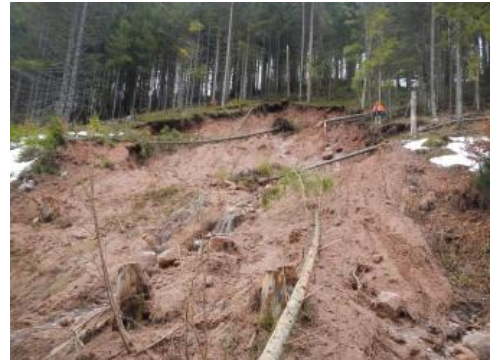
Abriss- sowie Transportbereich der Hangmure nahe des Oberen Großbachs
