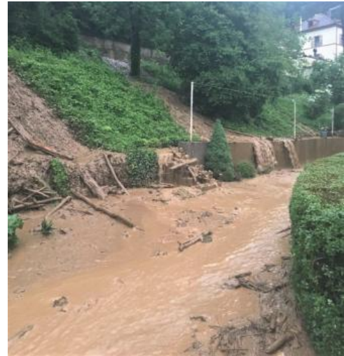
Straße Unteres Amtsfeld in Waldkirch nach dem Murgang vom 13.06.2016 (Foto: Feuerwehr Waldkirch)
