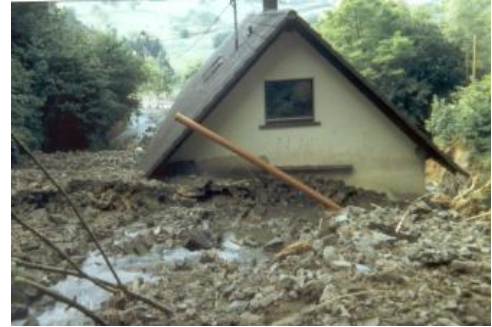
Verschüttetes Haus im Rußdobel nordöstlich Oppenau (Foto: Kühnle, 1995)
