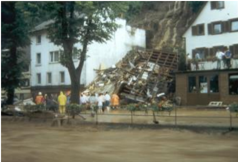
Zerstörter Neubau in Oppenau (Foto: Kühnle, 1995)
