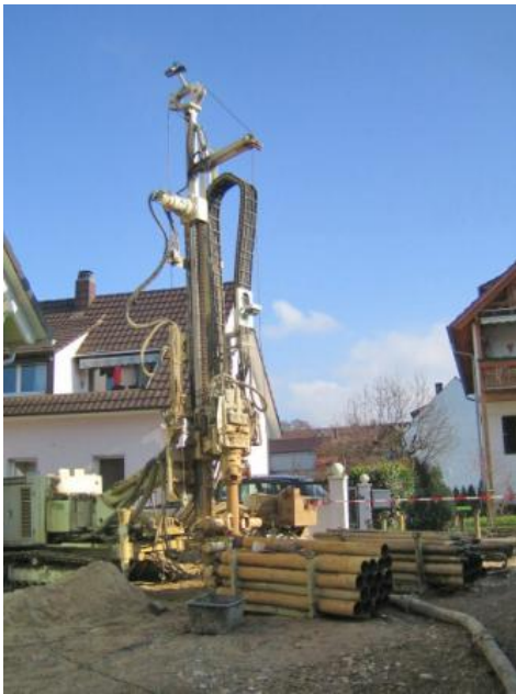
Bohrung für eine Erdwärmesonde
