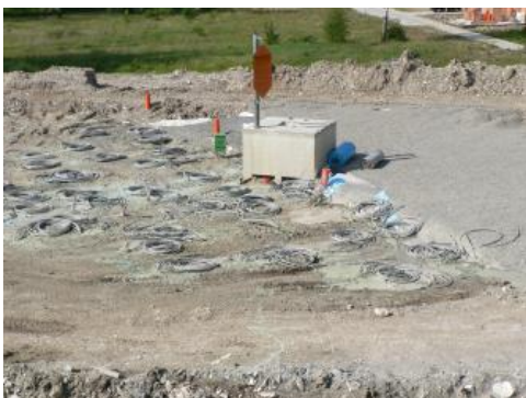
Bau eines Erdsonden-Wärmespeichers (Stober & Bucher, 2014)
