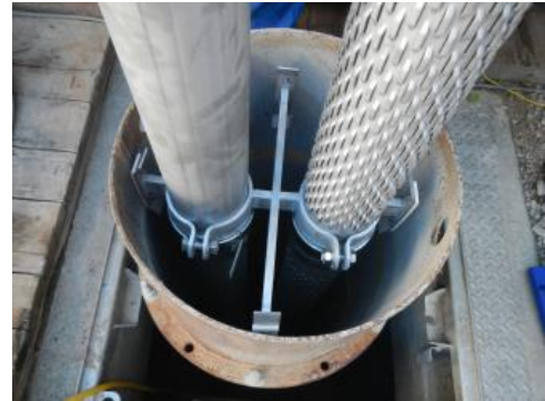
Einbau der Voll- und Filterrohre im Zuge des Neuausbaus des Absenkbrunnens BB 4
