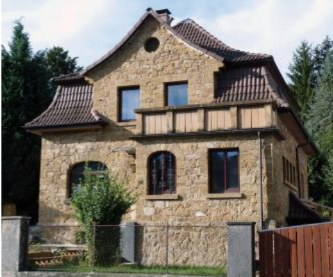
Haus in Schwäbisch Gmünd aus Angulatensandstein
