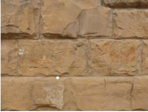
Sockelmauerwerk aus Angulatensandstein
