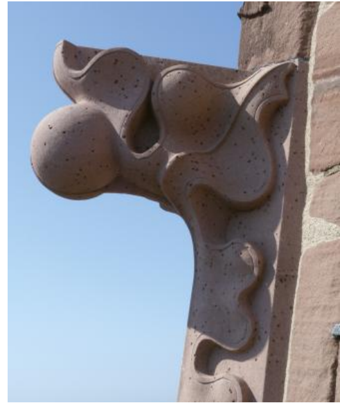
Neugefertigte Krabbe aus hellrotem Lahrer Sandstein am Freiburger Münster
