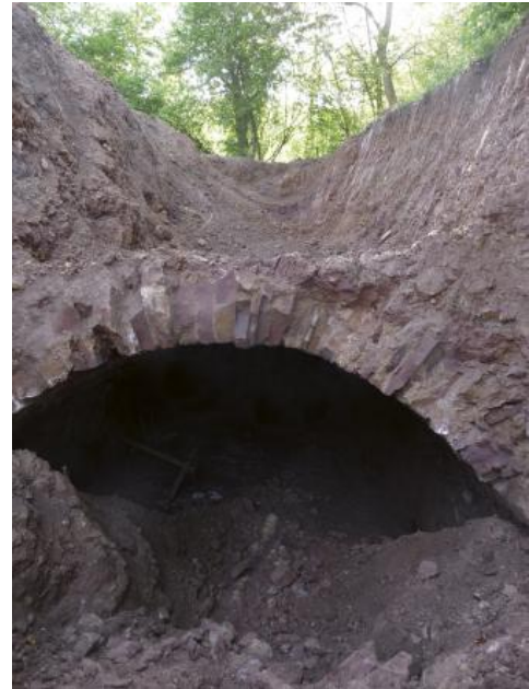
Durch Baggerarbeiten 2012 freigelegtes Portal des Oberen Schlierbergstollens
