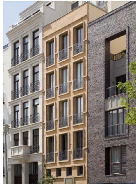
Cannstatter Travertin an einem Wohnhaus in Berlin-Mitte
