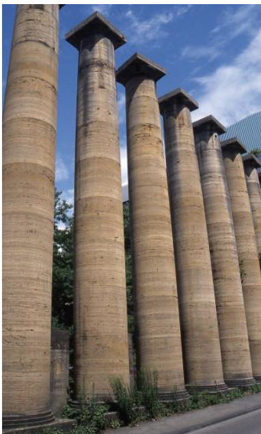
Travertinsäulen zwischen Steinbruch Lauster und Kraftwerk Münster
