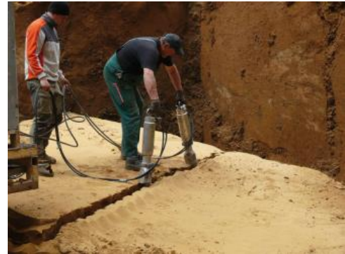
Hydraulisches Spaltgerät (Eisensandstein-Vorkommen der Banzenmühle bei Lauchheim)
