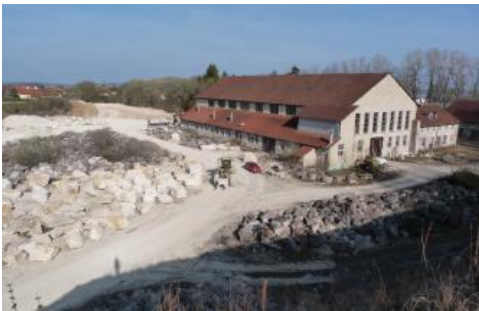
Werkhalle des Steinbruchs Gauingen
