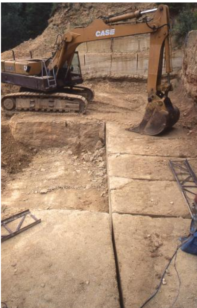
Abbau im Mittleren Lager mittels Schwertsäge und Bagger, Steinbruch O. Meier bei Tengen
