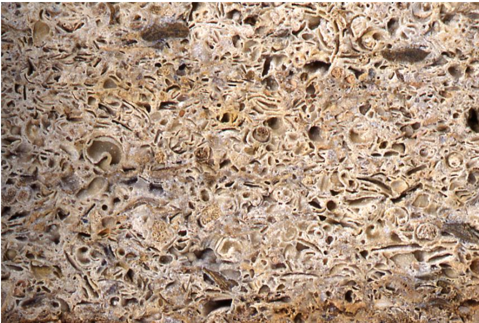
Fassadenplatte am Rathaus in Tengen aus Randen-Grobkalk
