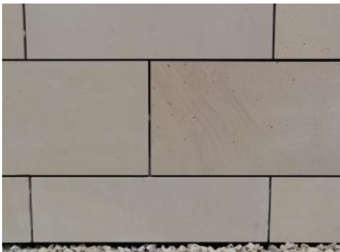
Fassadenplatten aus Niederhofener Sandstein an der Raiffeisenbank in Gundelfingen bei Freiburg
