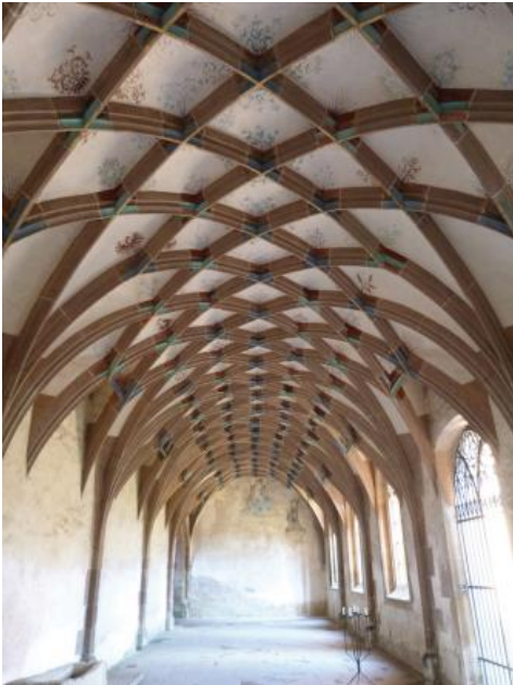
Netzgewölbe im Kloster Maulbronn aus gelblich braunem Schilfsandstein
