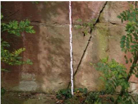
Roter Schilfsandstein im auflässigen Steinbruch bei Winnenden-Hertmannsweiler
