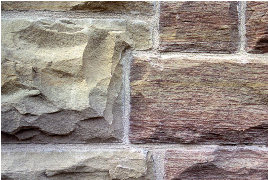
Quader an einem Gasthausgebäude in Bühlertann aus Schilfsandstein
