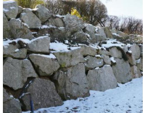
Rohblöcke aus Albtal-Granit als Sützmauer
