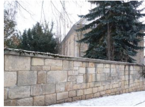
Friedhofsmauer und ev. Kirche Dettenhausen
