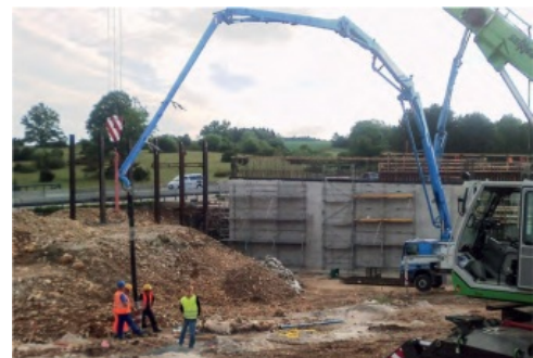
Verfüllung eines Hohlraums mit Beton (Foto: Fugro Consult GmbH; aus Raithel et al., 2015)
