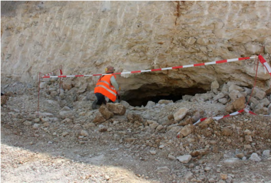
Oberer Eingang der Karsthöhle Tunnel Widderstall (Foto: Kielbassa, 2016)
