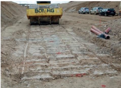
Dynamische Vorbelastung mit einer 32 t-Walze (Foto: Raithel et al., 2015)
