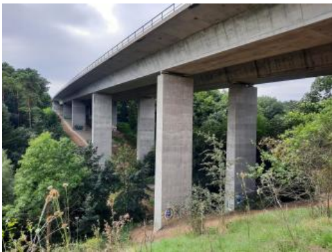
Ansicht der Kochhartgrabenbrücke
