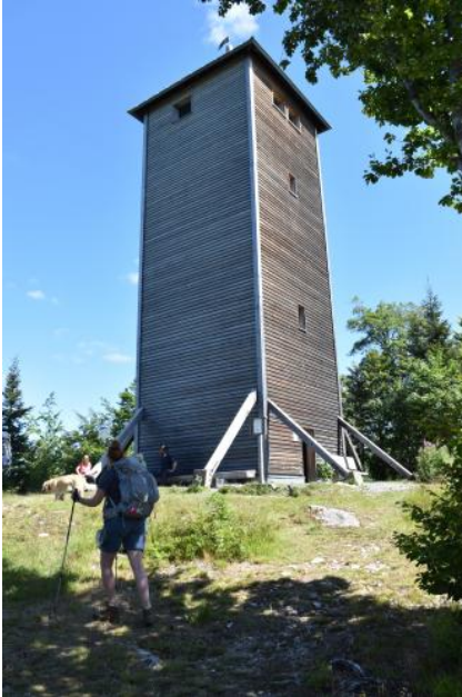
Der Lehenkopfturm südlich von St. Blasien
