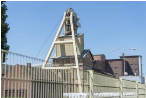
Schacht König Wilhelm bei Bad Friedrichshall; Foto: Salzbergwerk Bad Friedrichshall-Kochendorf
