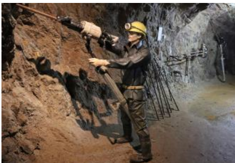
Darstellung des Bohrens von Sprenglöchern im Besucherbergwerk Finstergrund bei Wieden
