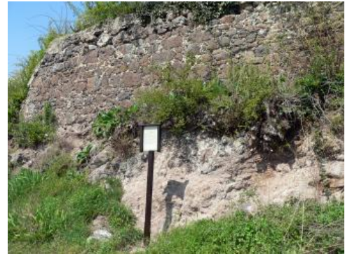
Geologischer Weinlehrpfad Achkarren – Station Stützmauer über Lavastrom
