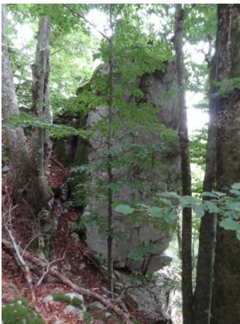
Zu sichernder Felsturm (Gefährdungspunkt G031) mit durchtrenntem, hangauswärts fallendem und vorbewegtem Fußbereich
