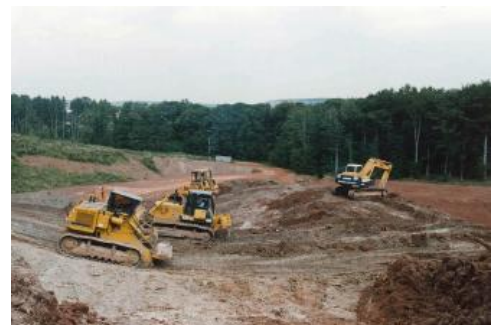
Abbau mit Bagger und Raupe in der Tongrube Maulbronn-Zaisersweiher
