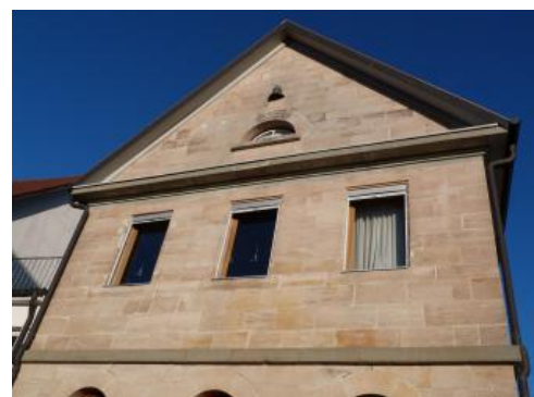
Mauersteine eines Wohnhauses aus Stubensandstein
