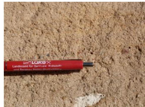
Detailaufnahme des Stubensandsteins aus dem Mauerwerk des Kirchengebäudes der katholischen Kirche St. Markus in Geislingen-Binsdorf.
