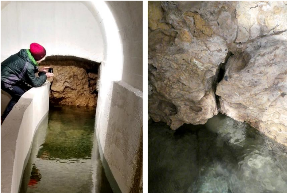
Fassung des Quellaustritts der Gallusquelle in einem Stollen mit Austritt aus der Oberjura-Massenkalk-Formation
