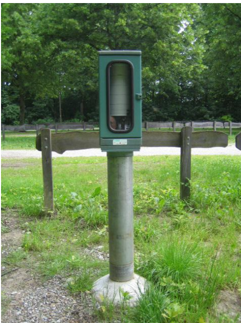
Grundwassermessstelle mit Schreiber zur kontinuierlichen Aufzeichnung der Wasserstandsänderungen.
