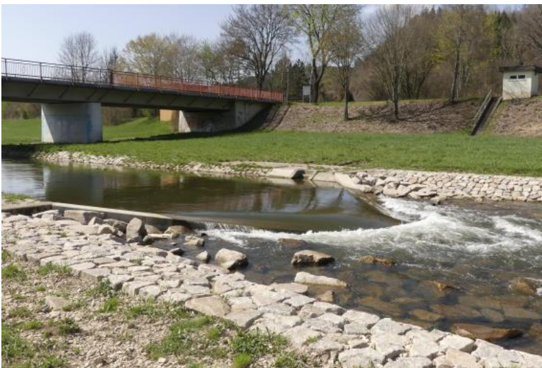
Pegel an einem Oberflächengewässer: Donaubrücke bei Tuttlingen-Möhringen
