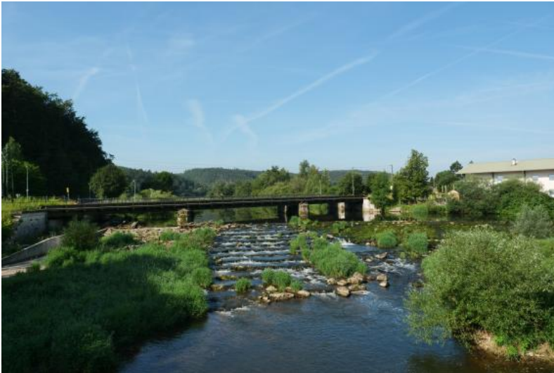
An der „Wehrwaage Immendingen“ wurde im Jahr 2001 der rechte Teil des Wehres in eine naturnahe Fischtreppe umgebaut.
