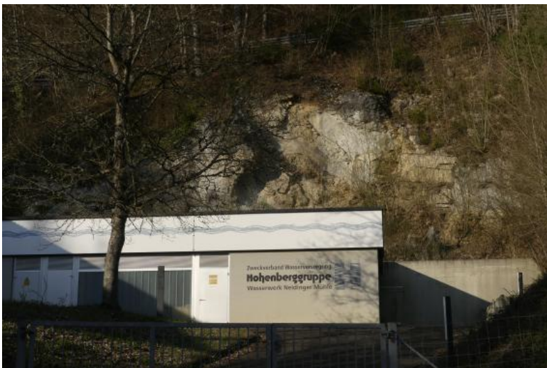
Das Wasserwerk Neidinger Mühle des Zweckverbandes Wasserversorgung Hohenberggruppe wurde Anfang der 2010er Jahre außer Betrieb genommen. Die aus dem Jahr 1974 stammende Anlage soll jedoch zur Deckung des gestiegenen Wasserbedarfs der Verbandsgemeinden wieder reaktiviert werden.
