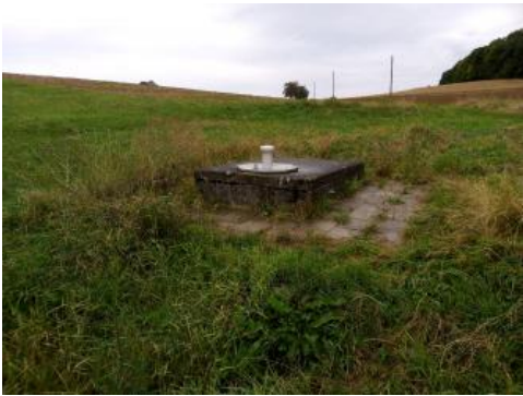
Quellschacht der Oberen Schwert-Quelle, Watterdingen
