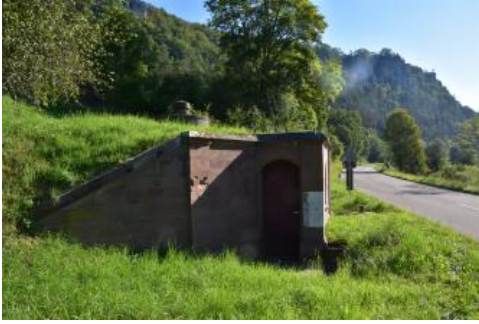
Quellfassung Langenbrunnen Werenwag, Hausen im Tal
