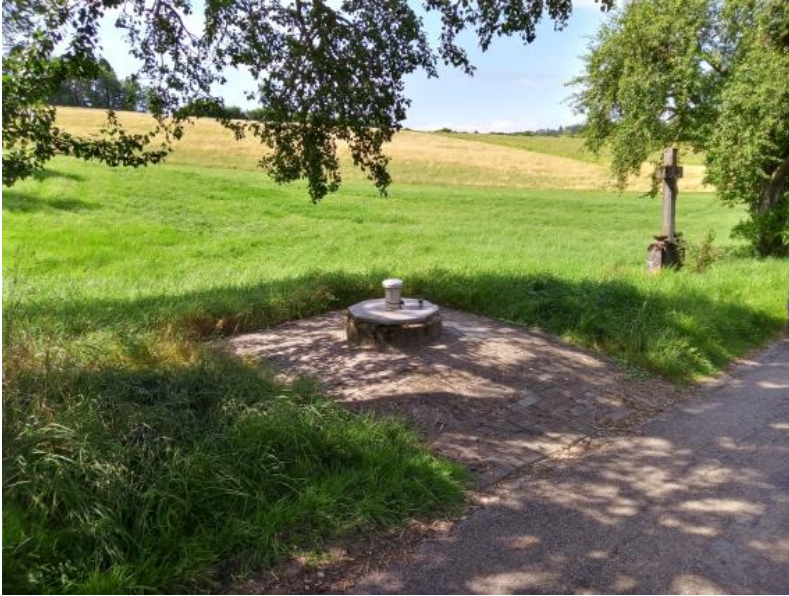
Quellsammelschacht der Oberen Schlauchquellen, Riedöschingen
