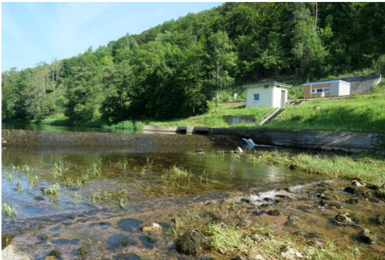
Aufstaubereich und Einlassbauwerk des Umleitungsstollens Immendingen mit einer Fischtreppe (rechts).
