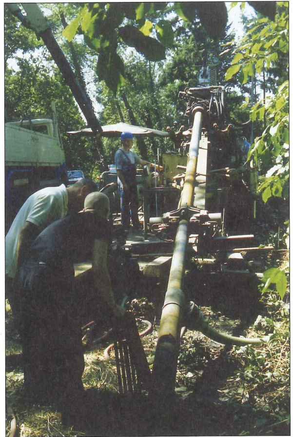
Abb. 11: Schräge Kernbohrung B1-West zur Erkundung des Tephrit-Vorkommens am Steingrubenberg bei Oberrotweil (vgl. Abb. 12) im Sommer 2001. Im Vordergrund ein Fernsehteam, das über die Erkundungsarbeiten berichtete.
