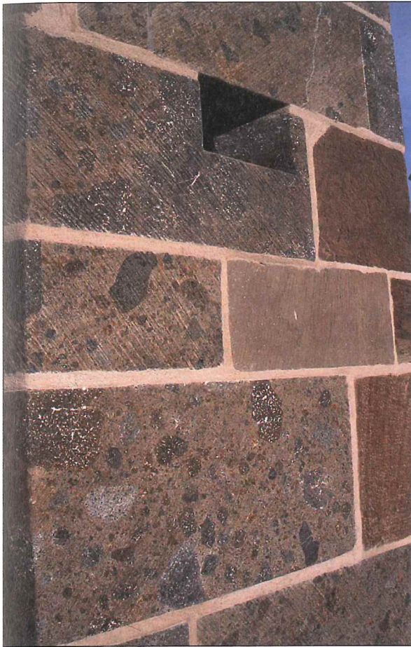
Abb. 19: Sanierter Großer Schneckenturm auf der Südseite des Breisacher Münsters. Beschädigter historischer Tuffstein wurde durch Pyroklastit aus Achkarren ersetzt, geschädigte Sandsteine mit Elsässer Sandstein aus Rothbach (Foto im Februar 2008).
