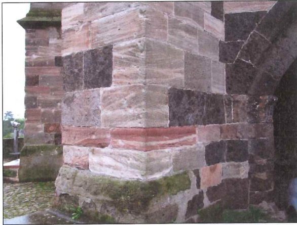
Abb. 3: Breisacher Münster, Pfeiler am Chorbau: Mauerquader von schwarzen und rötlichen Tephrit-Pyroklastiten des Kaiserstuhl-Vulkanismus neben gelblich-weißen und roten, schräg geschichteten Grobsandsteinen des Buntsandstein; beide Gesteinstypen wurden im 12./13. Jh. eingebaut (Foto B. STRIBNY).
