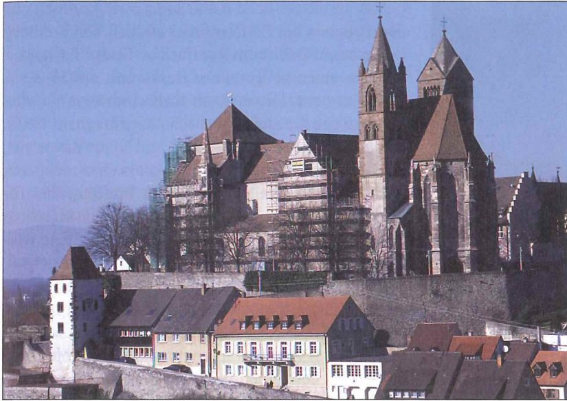
Abb. 2: Das Breisacher Münster St. Stephan; Blick aus Süden vom Eckartsberg. Restaurierungsmaßnahmen an der Süd- und Westseite (Foto Februar 2008).
